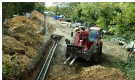
Travaux de raccordement au réseau du site de la société Vitalis
